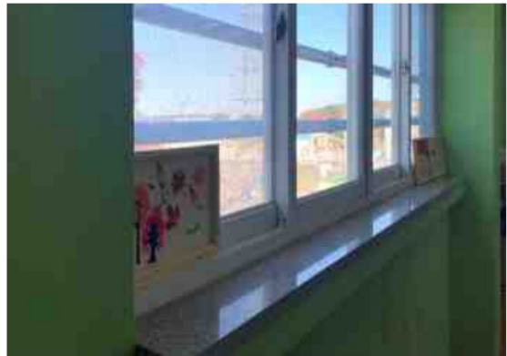
〈사례2 - 안전난간 설치〉
