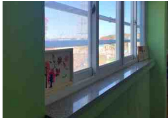
〈사례2 - 안전난간 설치〉
