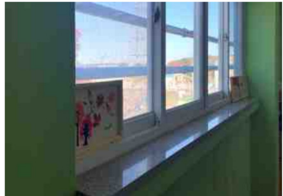
〈사례2 - 안전난간 설치〉
