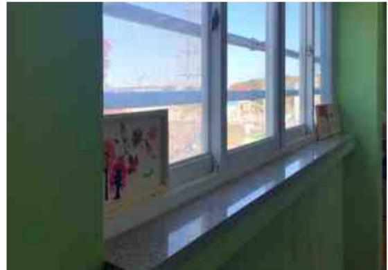
〈사례2 - 안전난간 설치〉
